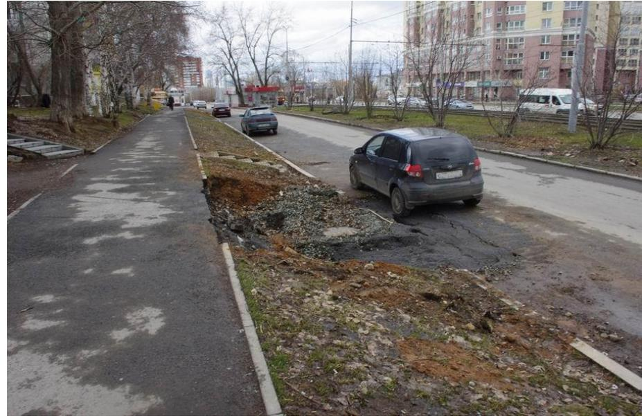
Рисунок – Пример образования грязевого осадка вследствие невыполненной рекультивации.
